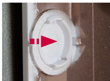
22 pav. Dangtelio įstatymas išėmus VDI plokštę
