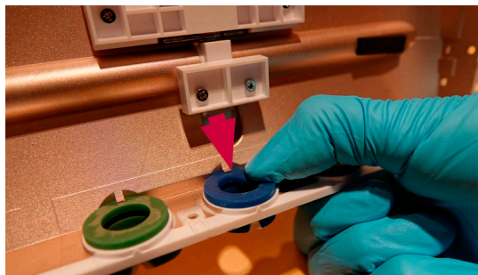
Figura 20 Scoateți inelul colorat deteriorat.
