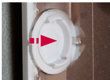
图 22 拆除 VDI 板后安装连接器盖
