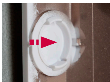
Afbeelding 22 Breng de afdekking aan als de VDI-plaat werd verwijderd
