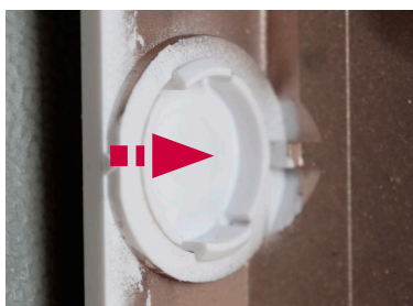
Obrázok 22 Ak bola odstránená doska VDI, nainštalujte kryt
