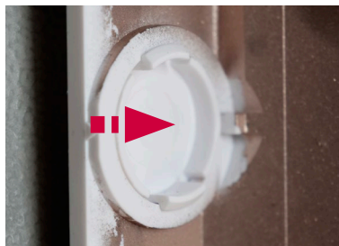
Kuva 27 Suojuksen asentaminen, jos VDI-kortti on irrotettu
